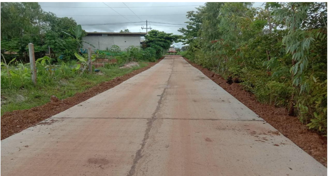
ถนนคอนกรีตบ้านหนองสนมหมู่ที่ ม.13 ซอยนาคำ
