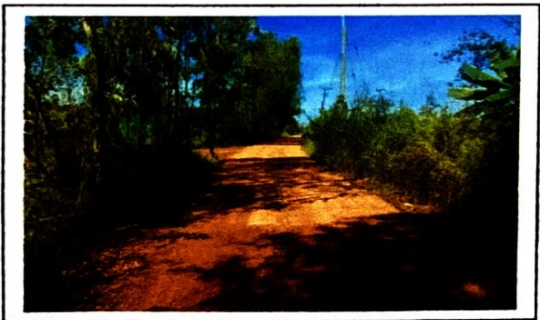
กม. ๐+๘๐๐ (สภาพสายทางโดยทั่วไป)
