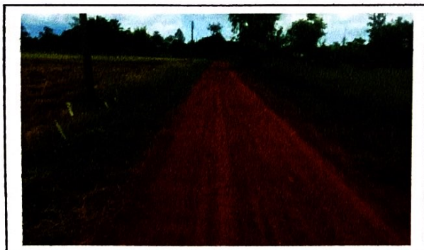
กม. ๐+๔๒๐ (สภาพสายทางโดยทั่วไป)
