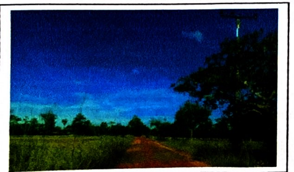
กม. ๑+๓๕๐ (สภาพสายทางโดยทั่วไป)
