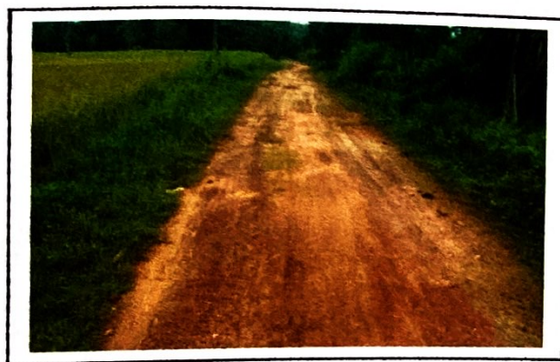
กม. ๓+๕๐๐ (สภาพสายทางโดยทั่วไป)
