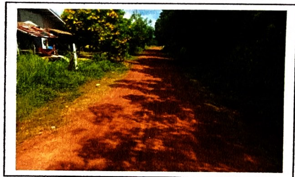
กม. ๐+๔๒๐ (สภาพสายทางโดยทั่วไป)
