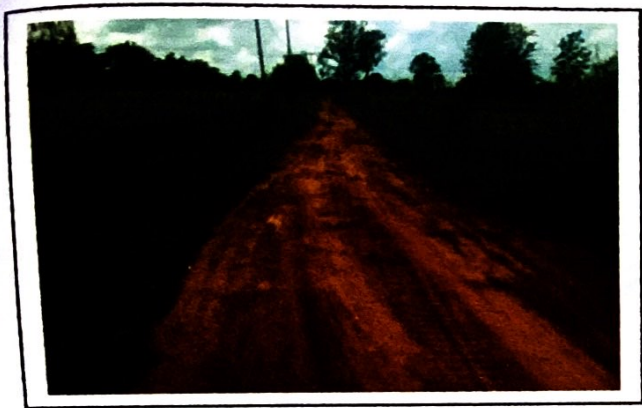
กม. ๓+๐๐๐ (สภาพสายทางโดยทั่วไป)
