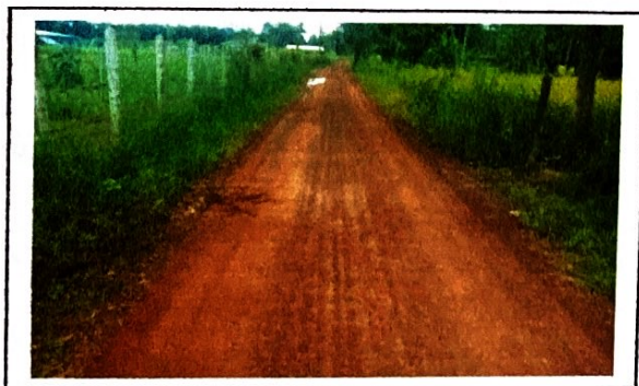
กม. ๑+๔๒๐ (สภาพสายทางโดยทั่วไป)
