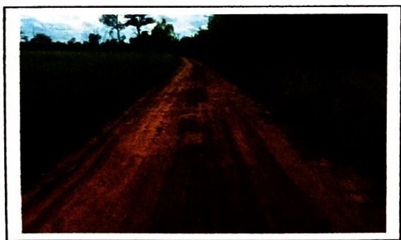
กม. ๐+๗๒๐ (สภาพสายทางโดยทั่วไป)
