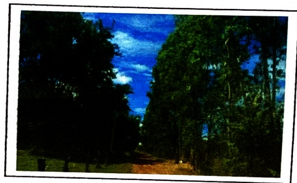
กม. ๔+๐๐๐ (สภาพสายทางโดยทั่วไป)
