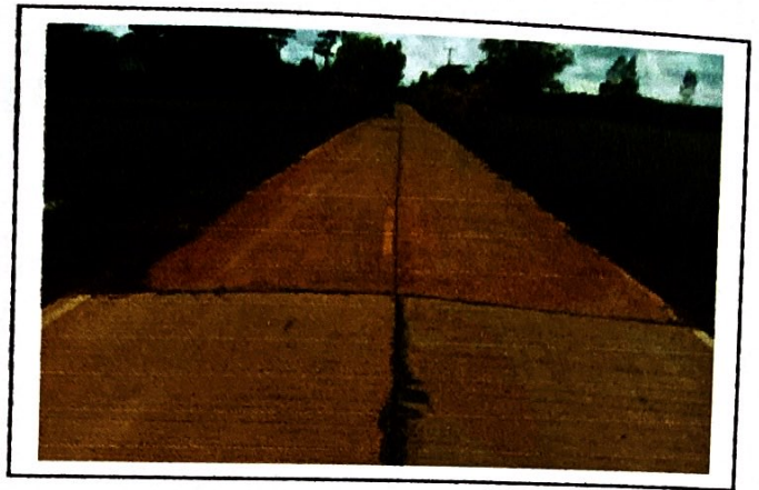
กม. ๒+๓๑๐ (สภาพสายทางโดยทั่วไป)
