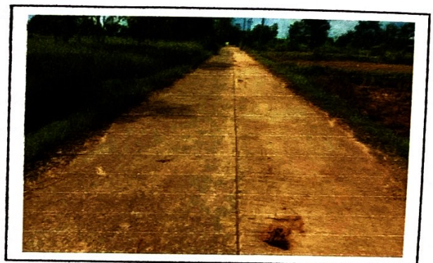
กม. ๓+๕๐๐ (สภาพสายทางโดยทั่วไป)
