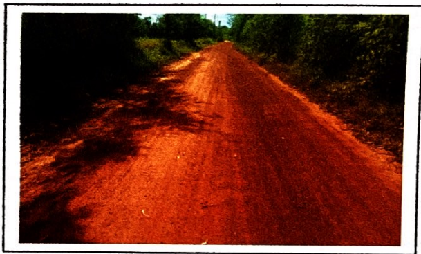
กม. ๐+๖๕๐ (สภาพสายทางโดยทั่วไป)
