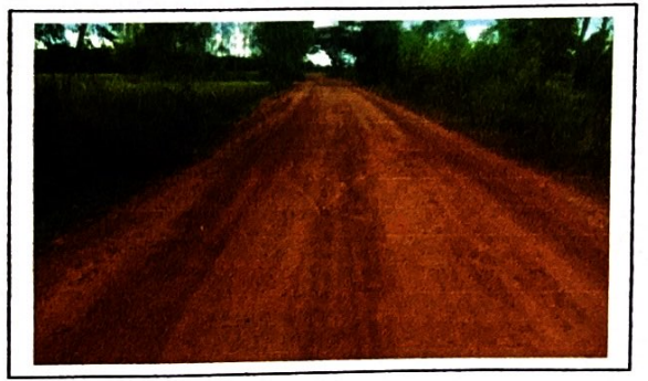
กม. ๑+๗๕๐ (สภาพสายทางโดยทั่วไป)
