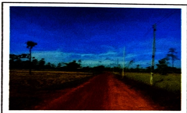
กม. ๓+๐๐๐ (สภาพสายทางโดยทั่วไป)
