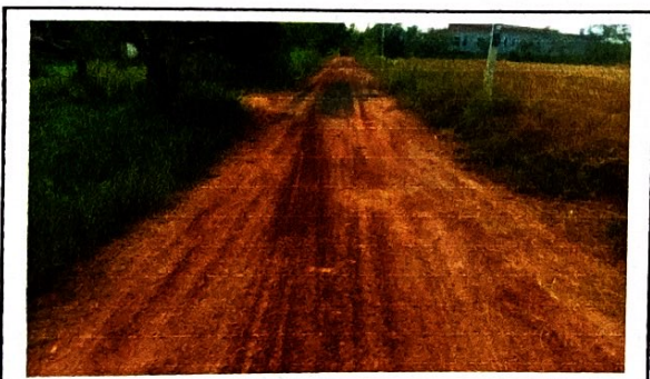
กม. ๑+๕๐๐ (สภาพสายทางโดยทั่วไป)
