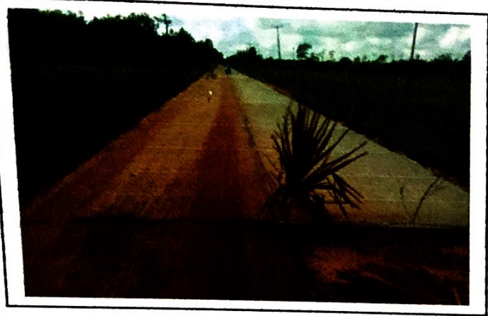
กม. ๑+๙๕๐ (สภาพสายทางโดยทั่วไป)
