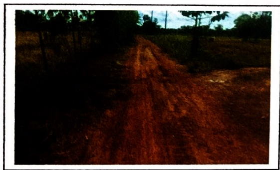
กม. ๑+๒๒๐ (สภาพสายทางโดยทั่วไป)
