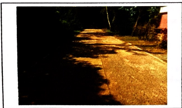
กม. ๐+๗๕๐ (สภาพสายทางโดยทั่วไป)
