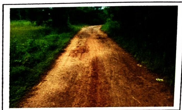
กม. ๔+๕๐๐ (สภาพสายทางโดยทั่วไป)
